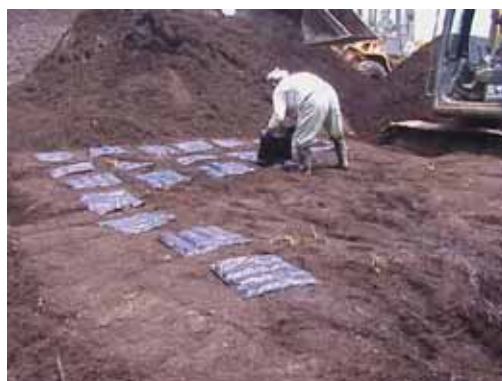
パイル断面に並べた吸着マットを被覆する様子
