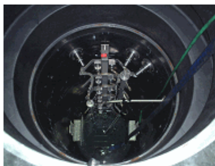
写真 2 高圧タンク内部
