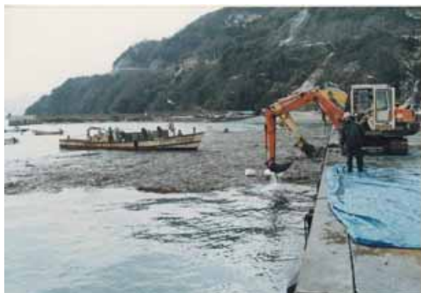
写真 1 0 岸壁から重機による回収
