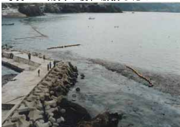
写真8 荒天の後、破損したOF
