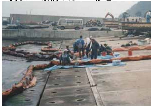
写真9 破損したOF修理
