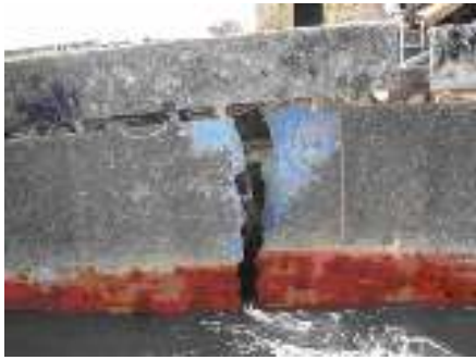
写真14. 船体への亀裂
