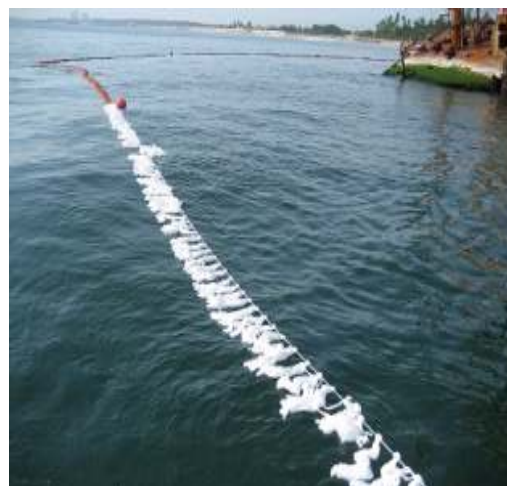
写真10. 油防除資材の展張
