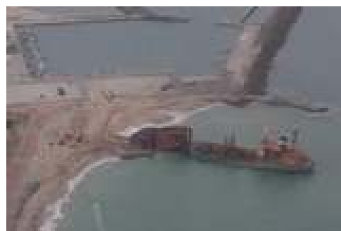
写真17. 牽引作業の完了
