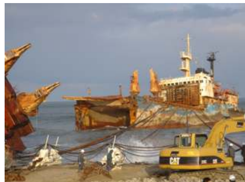
写真16. 船尾部の牽引作業
