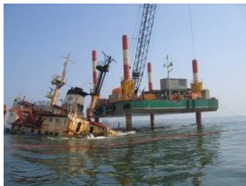
写真6. SEP台船による撤去作業
