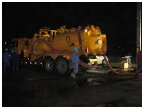
写真3 雨水枡内の強力吸引車による油水吸引
