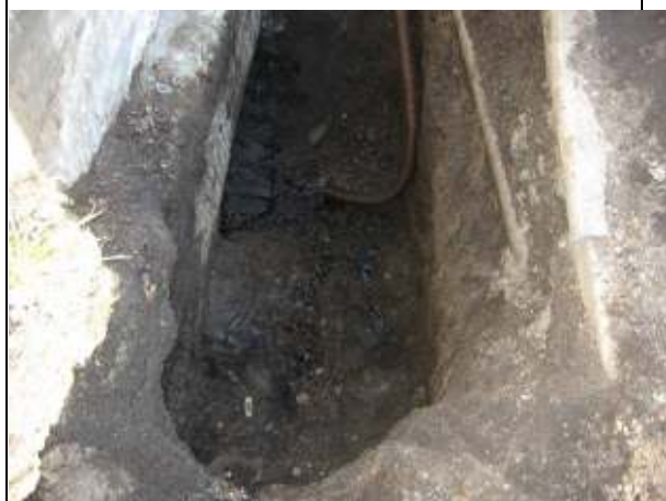
写真6 掘削箇所・滲み出る油分を吸引中
