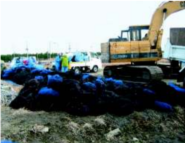
アイアンフック付重機によるダンプ積込作業
