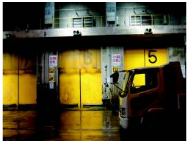
廃棄処理施設の内部
