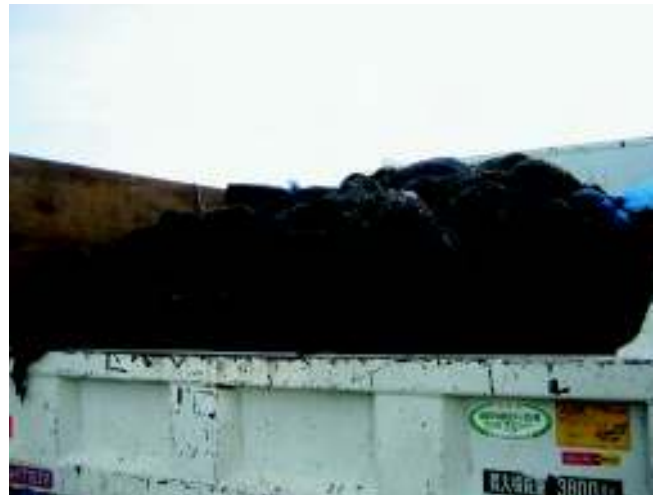
詰め込まれ廃棄処分施設に向かうダンプ
