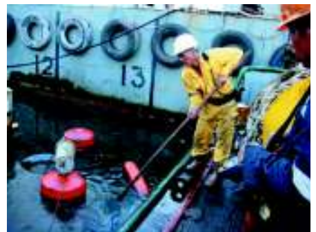
流出した油の回収に使われる石油連盟の油回収機
